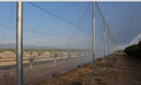
Su estructura está formada por un conjunto de postes metálicos sobre los que se instala una **red metálica** que va a soportar el revestimiento exterior de **malla**. En las paredes laterales se puede colocar una cubierta de plástico enrollable a modo de ventana.
